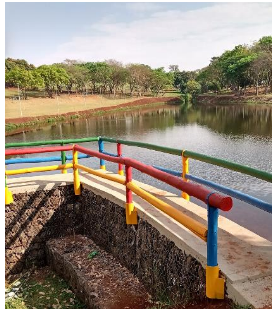
Registro fotográfico depois da obra de intervenção, concluída em junho de 2020
