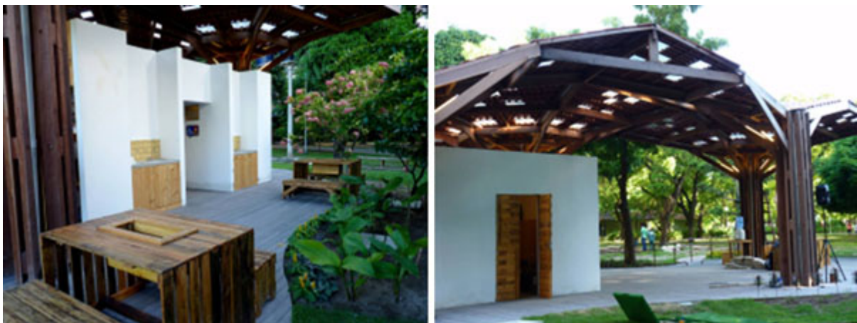
Figura 2: Entrada das instalações sanitárias e entrada do espaço principal.
