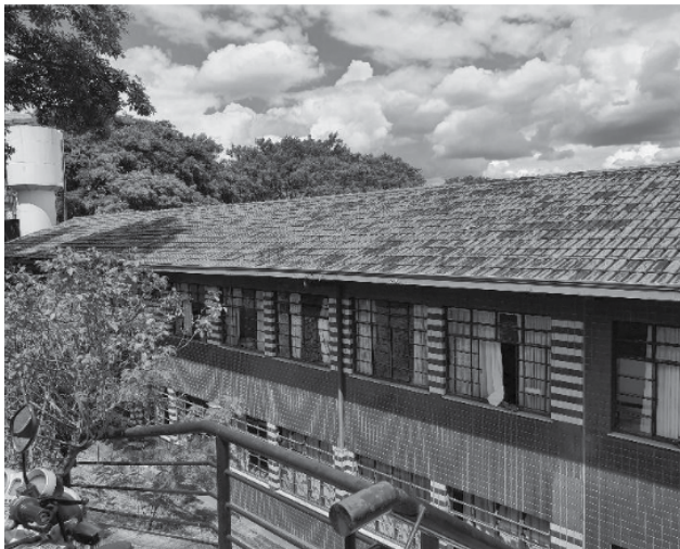
Figura 7. Foto da Entrada da EMHJS. Fonte: Consultorias, 2020.
