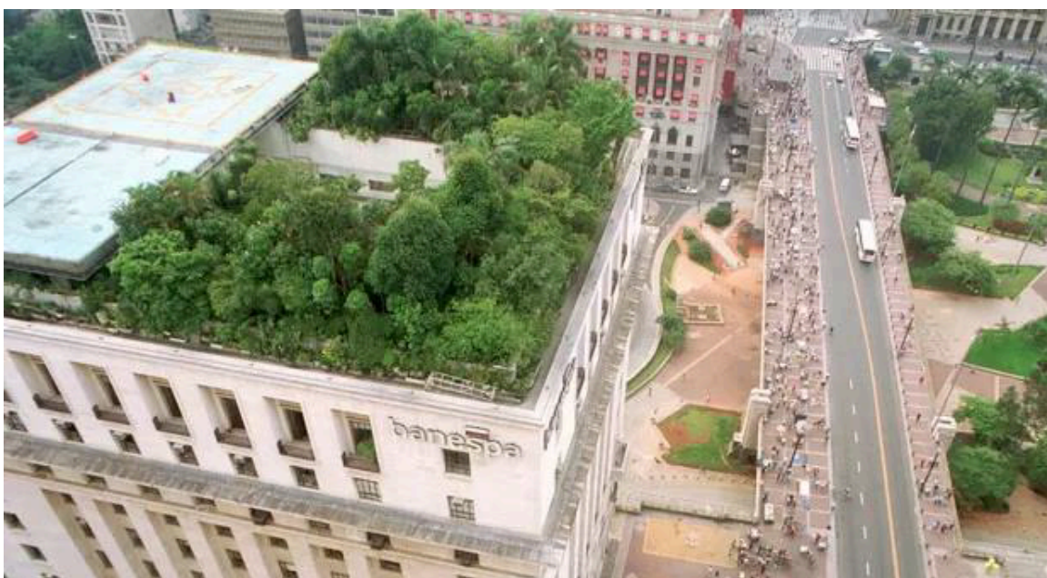
Fonte: Edifício Conde Matarazzo – Sede da Prefeitura de São Paulo, São Paulo (SP) Foto: Hêlvio Romero
