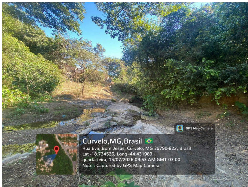
Figura 1.17. Rua Eva, Bom Jesus (Lat -18.734526, Long -44.431989). Leito rochoso seco do córrego com ocupação residencial visível na margem superior, evidenciando a proximidade das construções em relação à calha.
