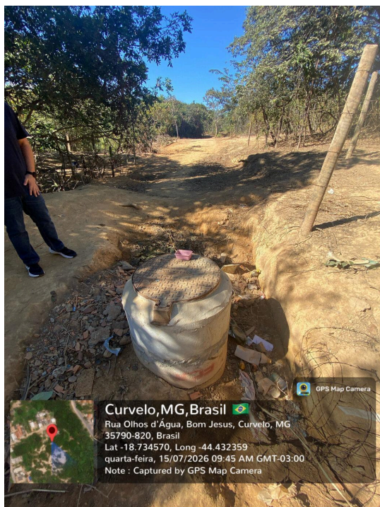
Figura 1.13. Rua Olhos d'Água, Bom Jesus (Lat -18.734570, Long -44.432359). Segundo poço de visita (manilha) da rede de esgotamento sanitário identificado no percurso, situado em trilha de acesso dentro da poligonal, com resíduos de construção civil ao redor.
