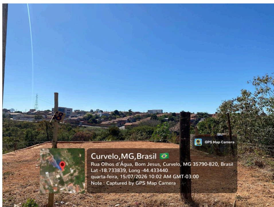
Figura 1.23. Rua Olhos d'Água, Bom Jesus (Lat -18.733839, Long -44.433440). Demarcação, cercamento e fundação de casa, indicando nova construção.
